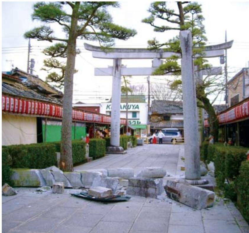
被害は大きく 参道の6m鳥居は倒壊、7・5mの鳥居は一部損傷、今後倒壊の危険があるため、崇敬者の安全を考慮し、撤去。
